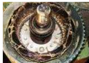
分解後のモーター コイルが焼損している
