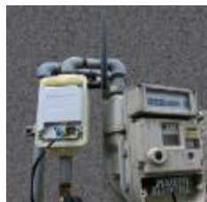
ガス水道メーターIoT化
