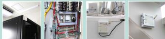
サーバー室 温湿度監視(無線) / 分電盤 電力監視(無線) / 事務所 無線中継局 / 階段ロビー 温湿度監視(無線)
