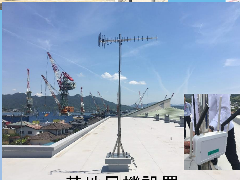
基地局機設置
