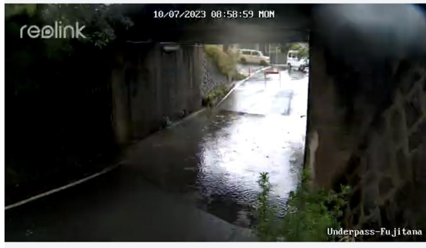
市内に水位センサーと監視カメラを設置
